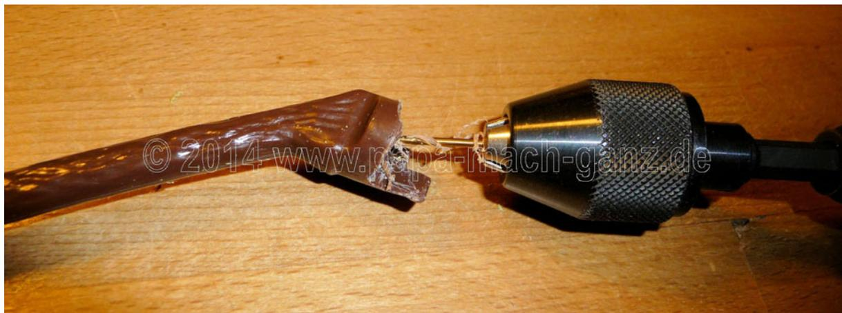
10. Die Schraube wird jetzt probeweise ein kurzes Stück in den Mast herein- und wieder rausgedreht. Dadurch wird ein Gewinde eingeschnitten und das Drehen der Schraube später erleichtert.
